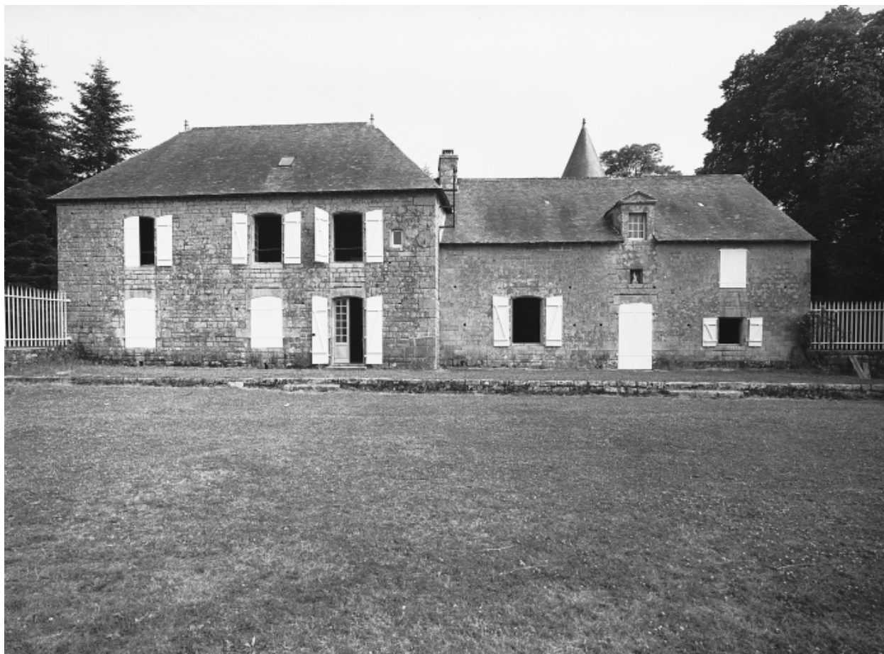
Vue générale de la façade sud
