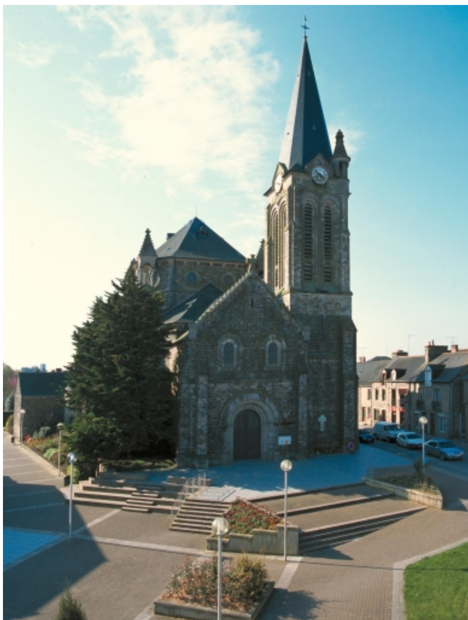
Vue générale nord
