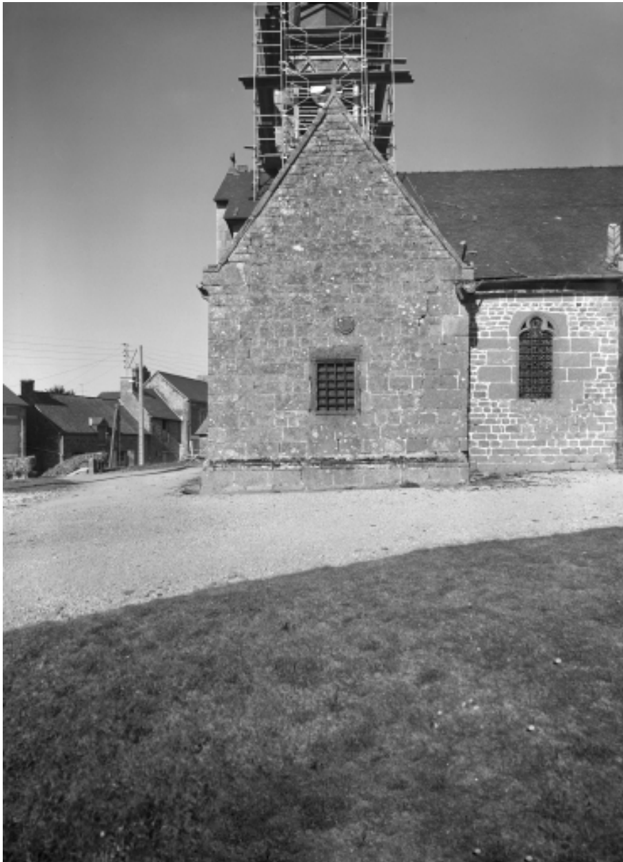
Elévation Sud, chapelle des Fonts : vue générale
