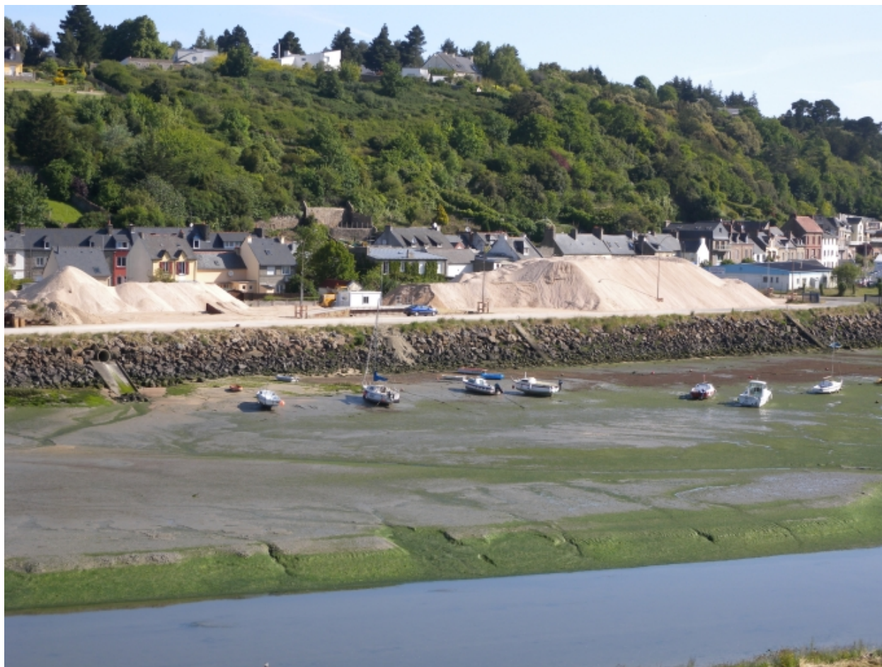
Vue des enrochements en aval du terre-plein de la Ville-Gillette, qui reçoit les dépôts de sable et de maërl
