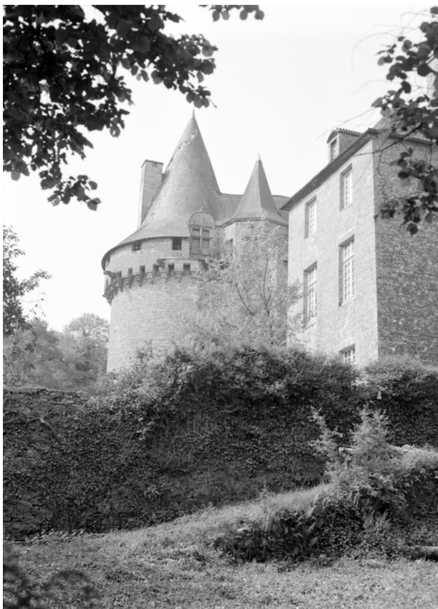
Vue générale prise du nord-est (état en 1984)
