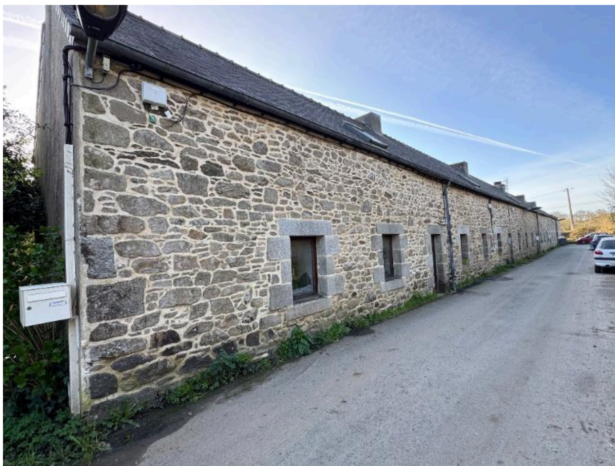
Logements des ouvriers teilleurs. Vue générale nord-ouest
