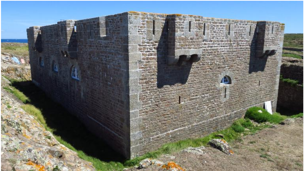
Île-d'Houat, batterie du Béniguet, corps de garde crénelé, angle nord-est.
