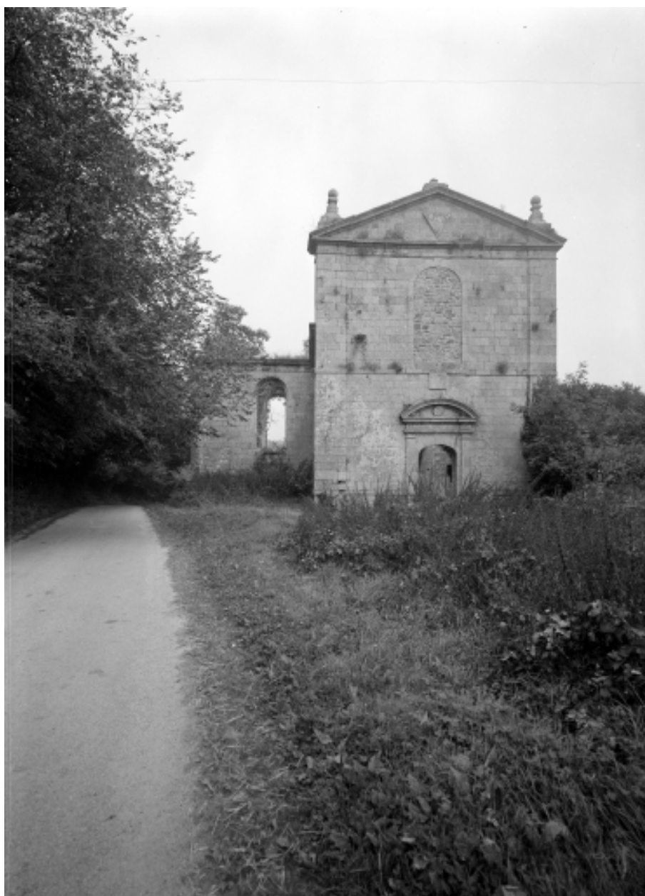
Façade antérieure de la chapelle
