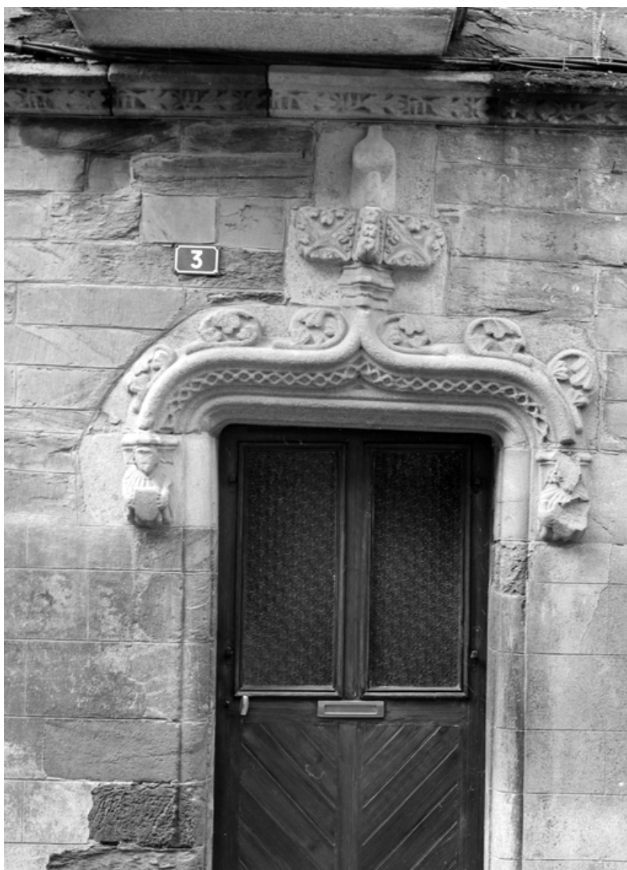
Maison : la porte (état en 1984)
