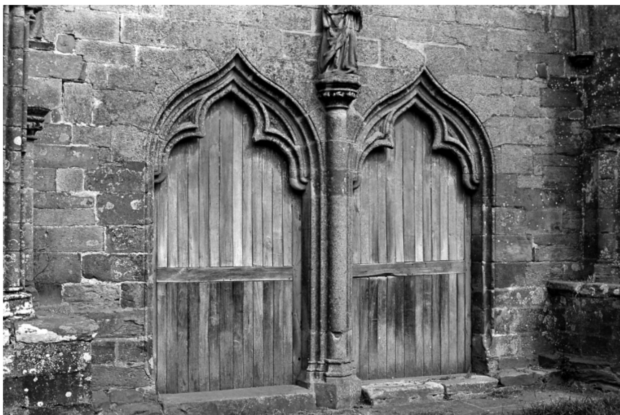
Portes de la façade ouest
