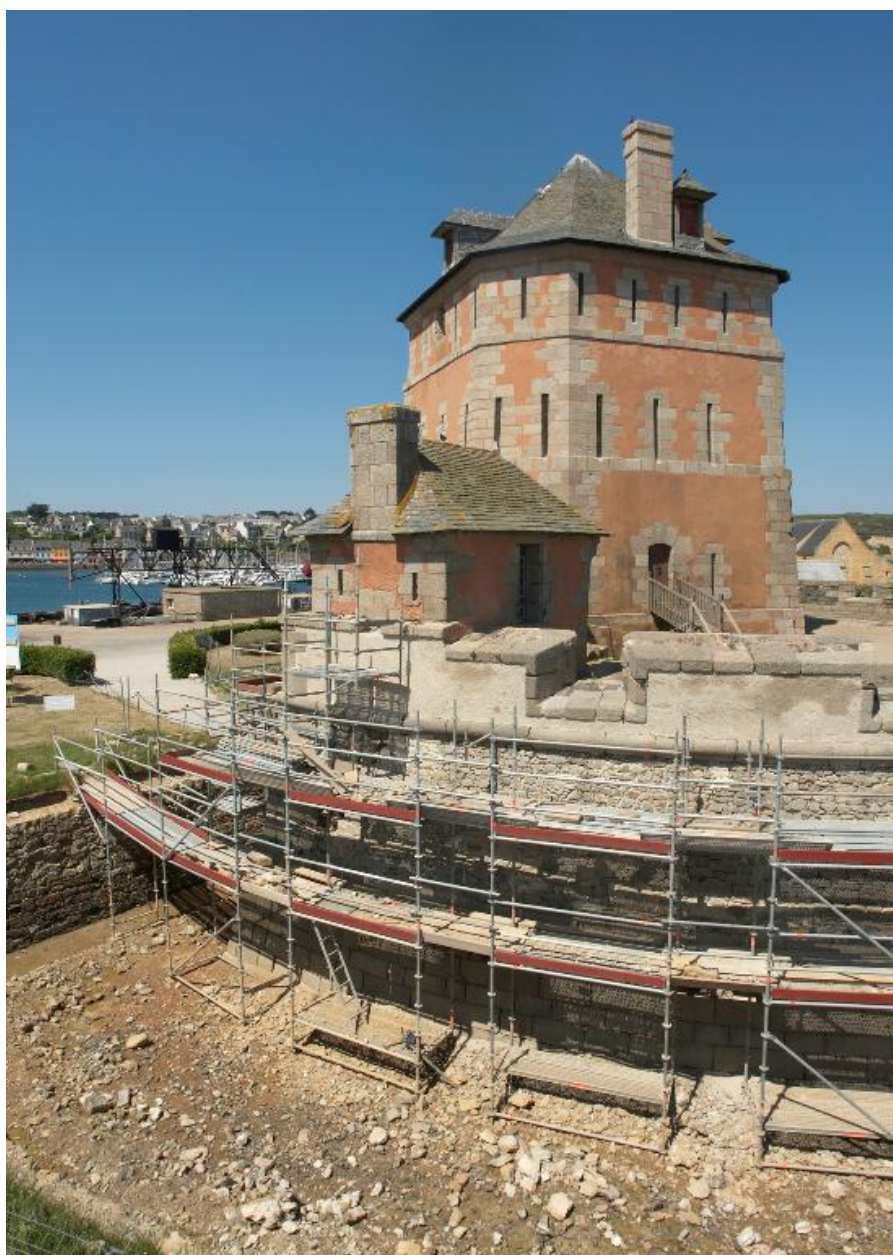
Camaret-sur-Mer : vue de la tour Vauban, restauration de l'escarpe de la batterie
