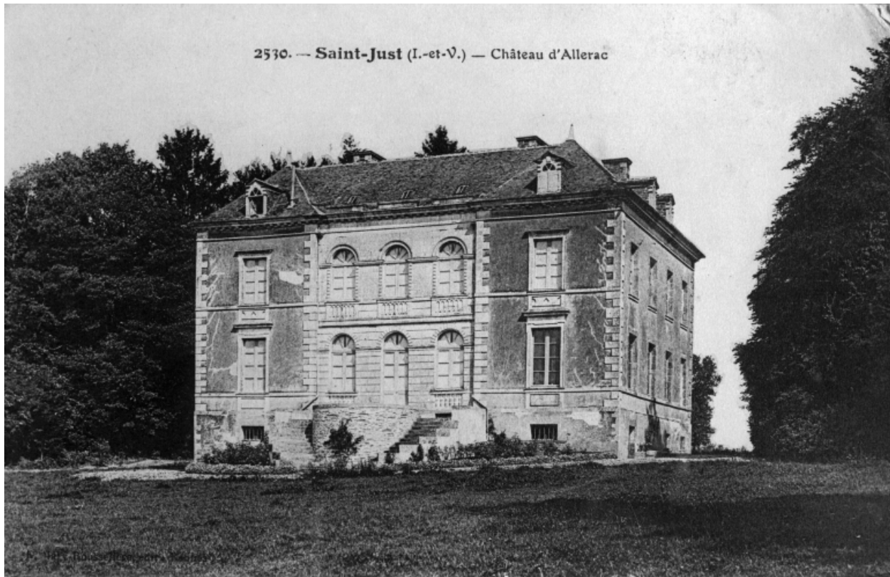
Le château moderne : façade postérieure
