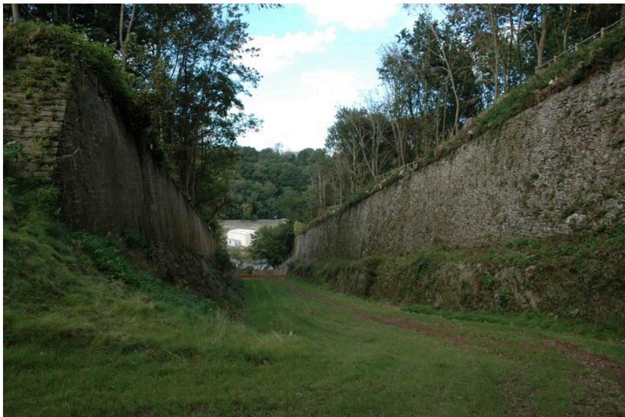
Vue de l'ouvrage à cornes de Quéliverzan
