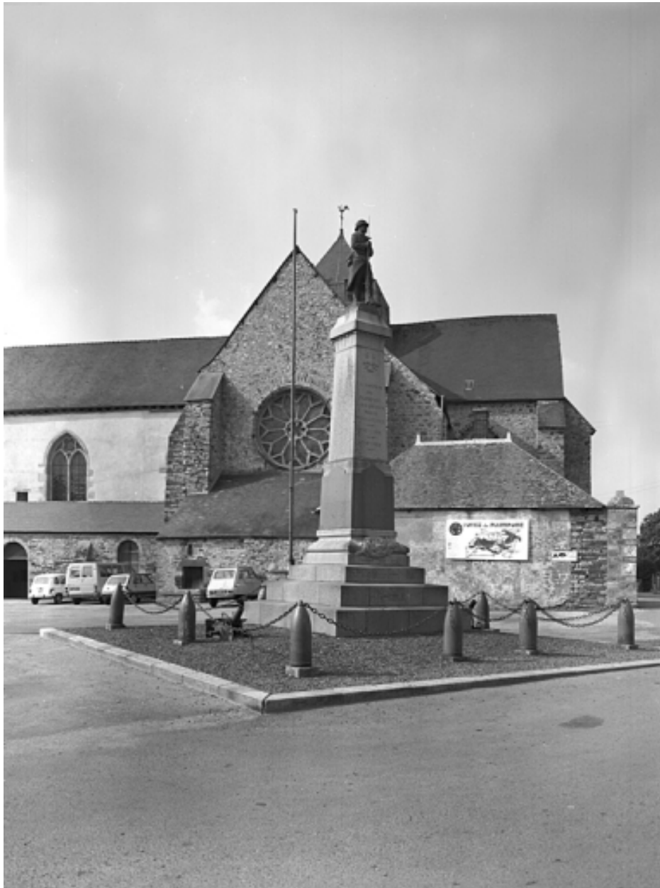
Eglise ; transept sud, vue de situation
