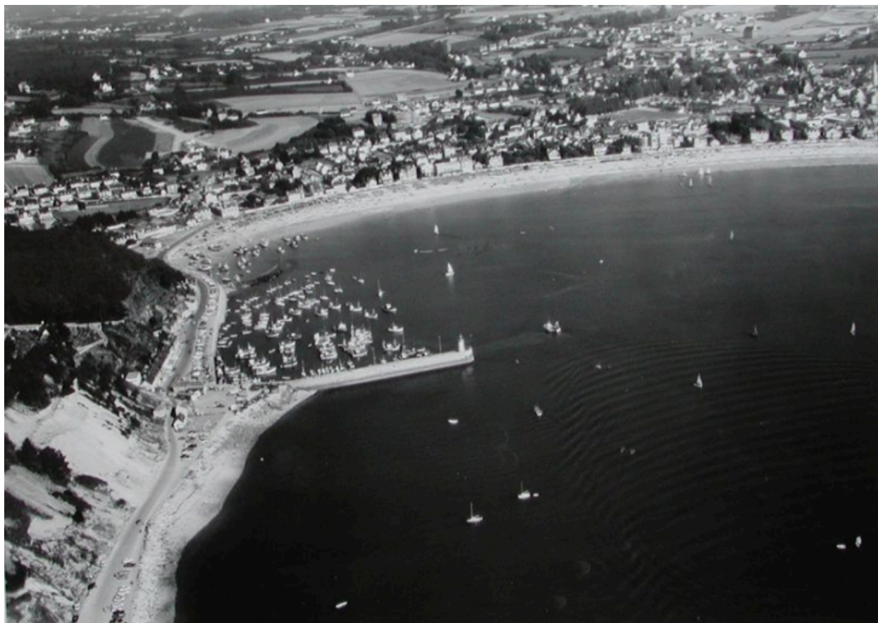
Vue aérienne du port d'Erquy vers 1971 (Fond Henrard AD 22)
