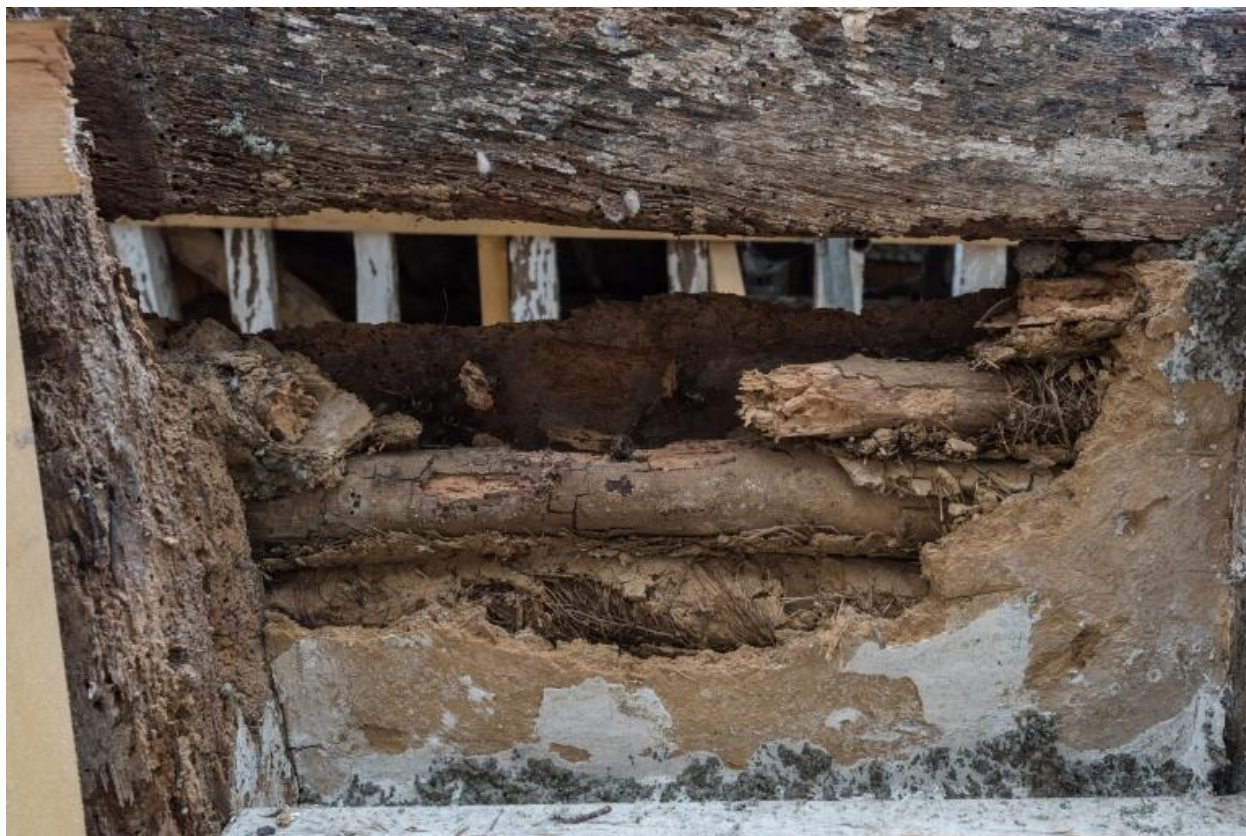
Quenouilles et enduit à la terre comblant l'espace entre les solives (restauration en 2021).
