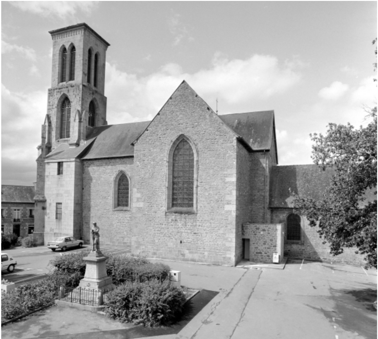
Elévation Sud : vue générale
