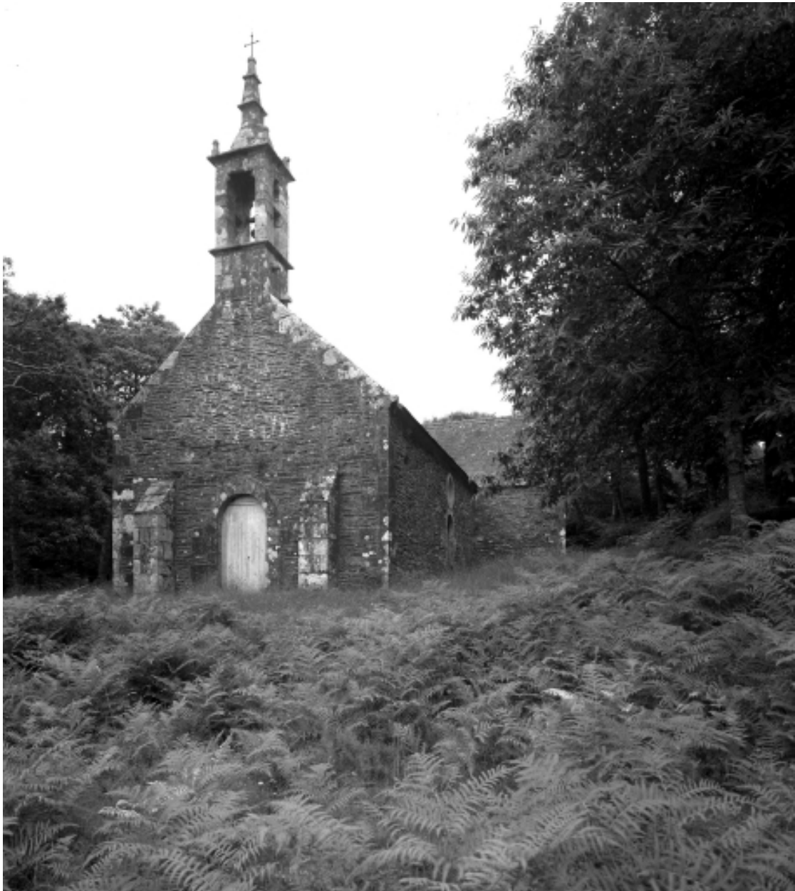
Saint-Thois, chapelle Saint-Laurent : vue générale sud-ouest, état en 1966
