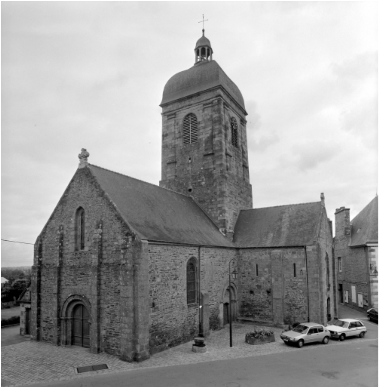
Elévation Sud-Ouest : vue générale
