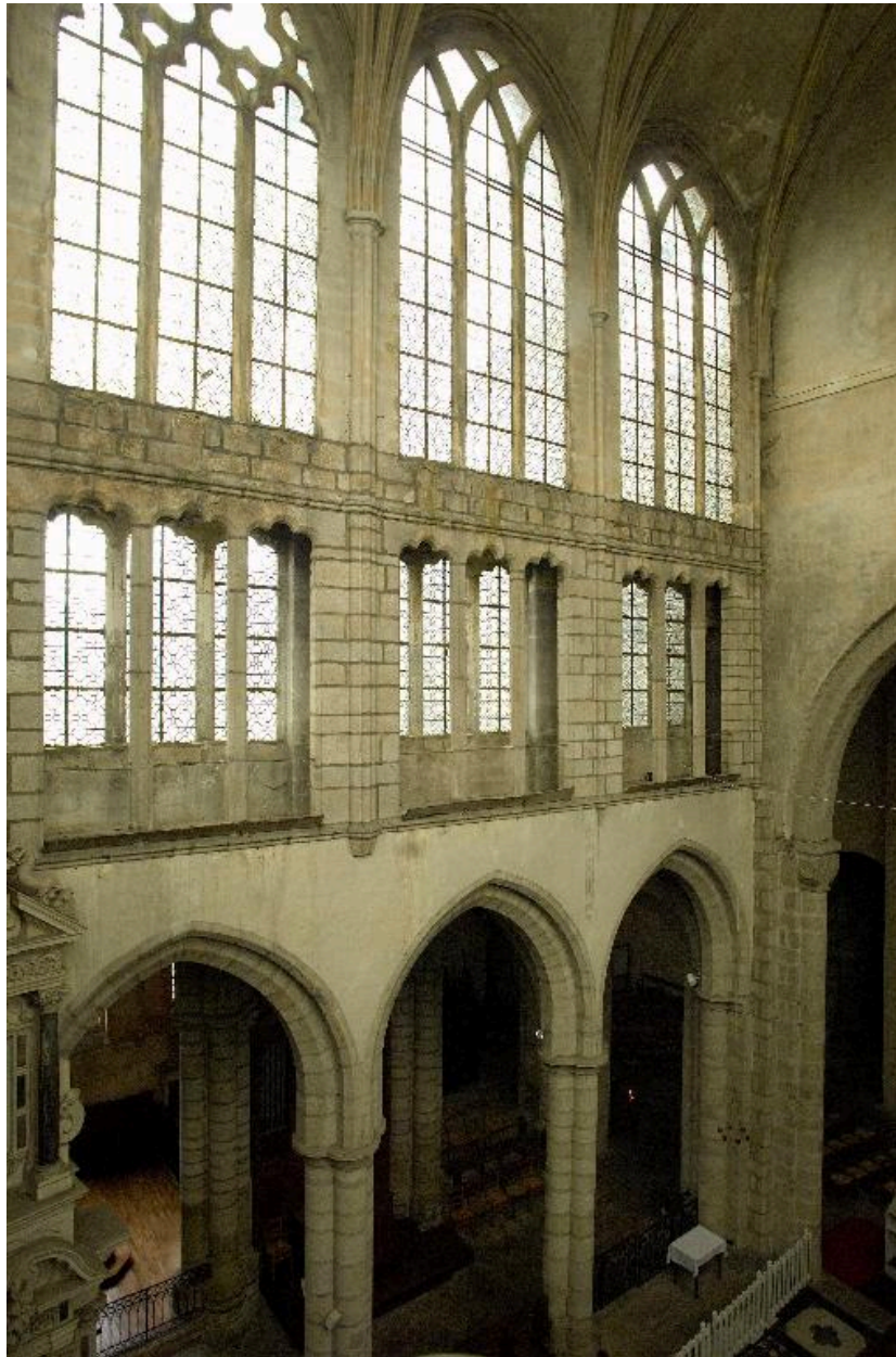
Choeur, intérieur, élévation du côté sud.
