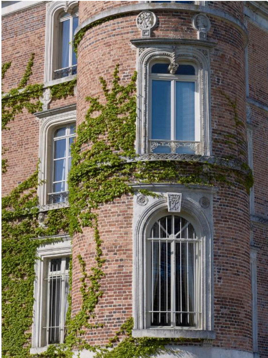
Détail de la tour formant l'angle
