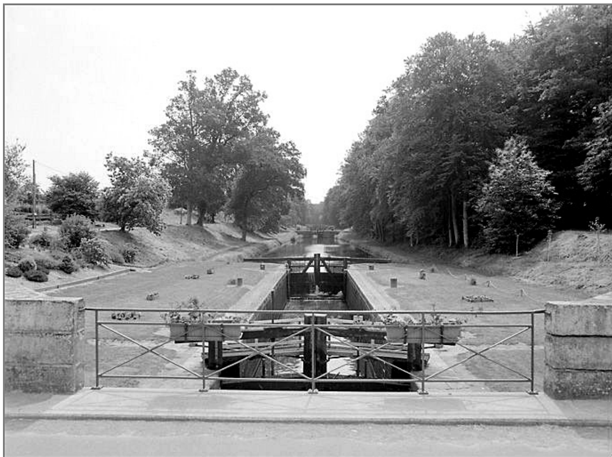
Ecluse, vue générale
