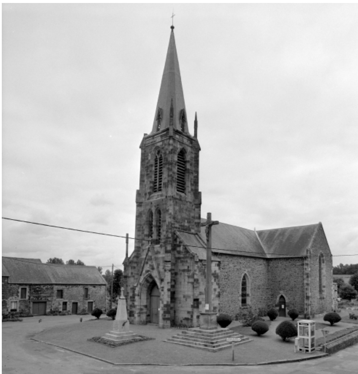
Elévation Sud-Ouest : vue générale
