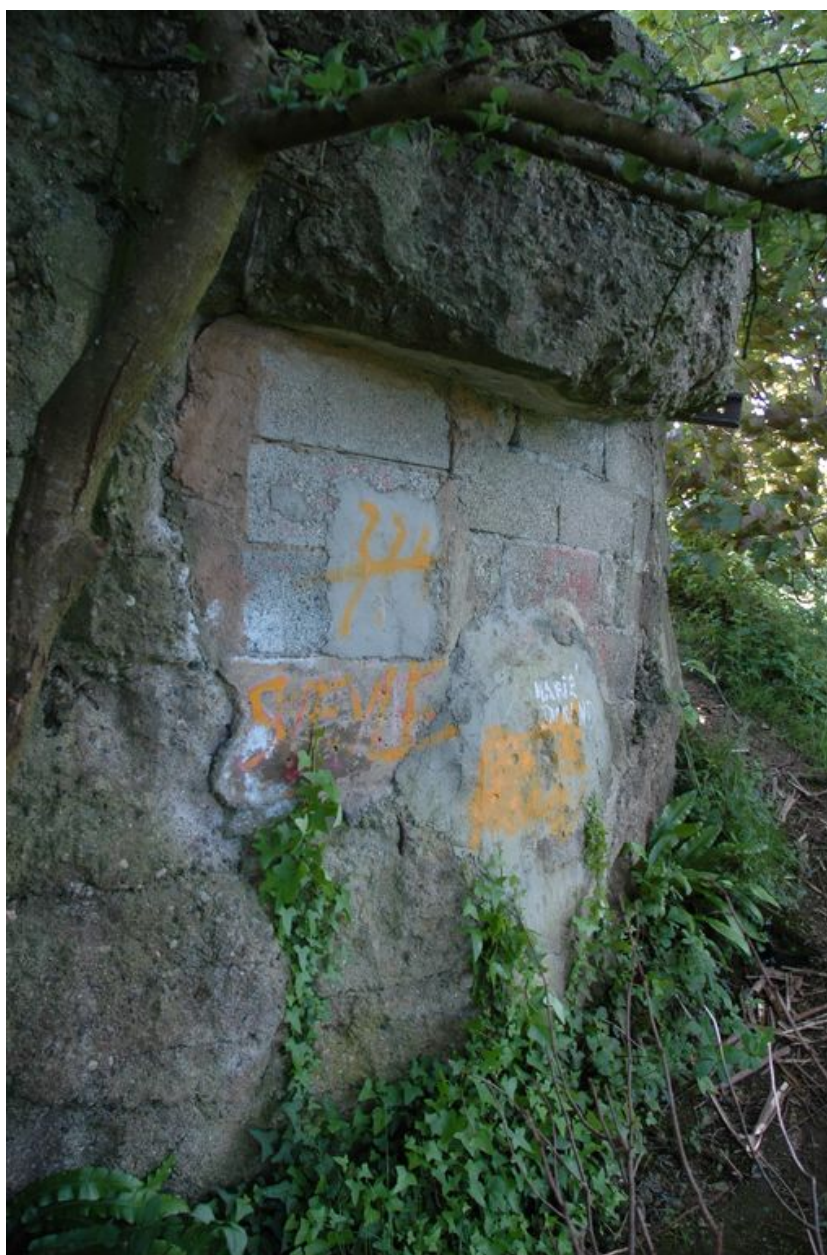
Vue des vestiges d'un bunker - casemate (poste d'observation d'artillerie ?) (état en 2007)
