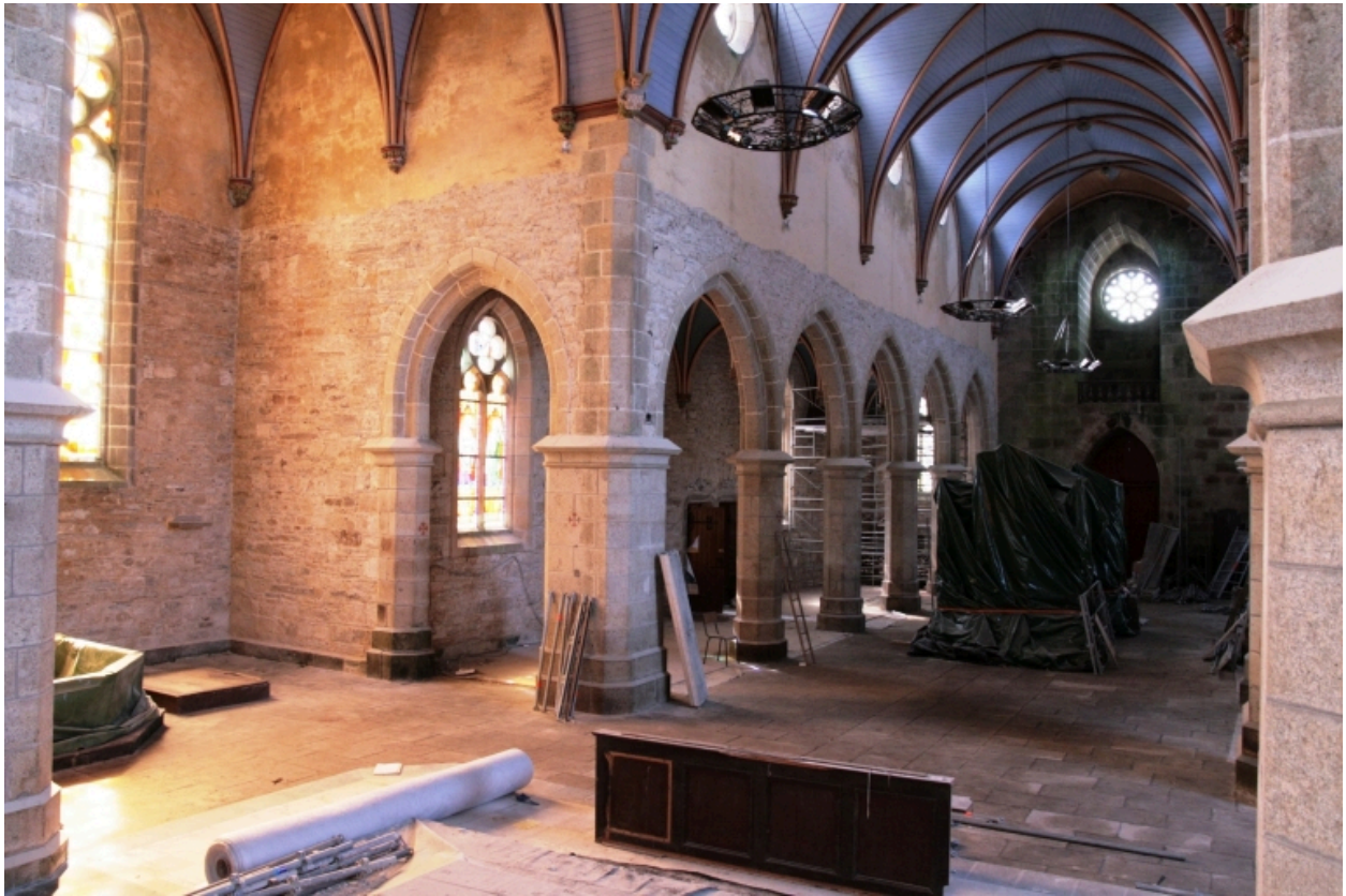
Hanvec, église paroissiale Saint-Pierre : vue transversale sud-ouest
