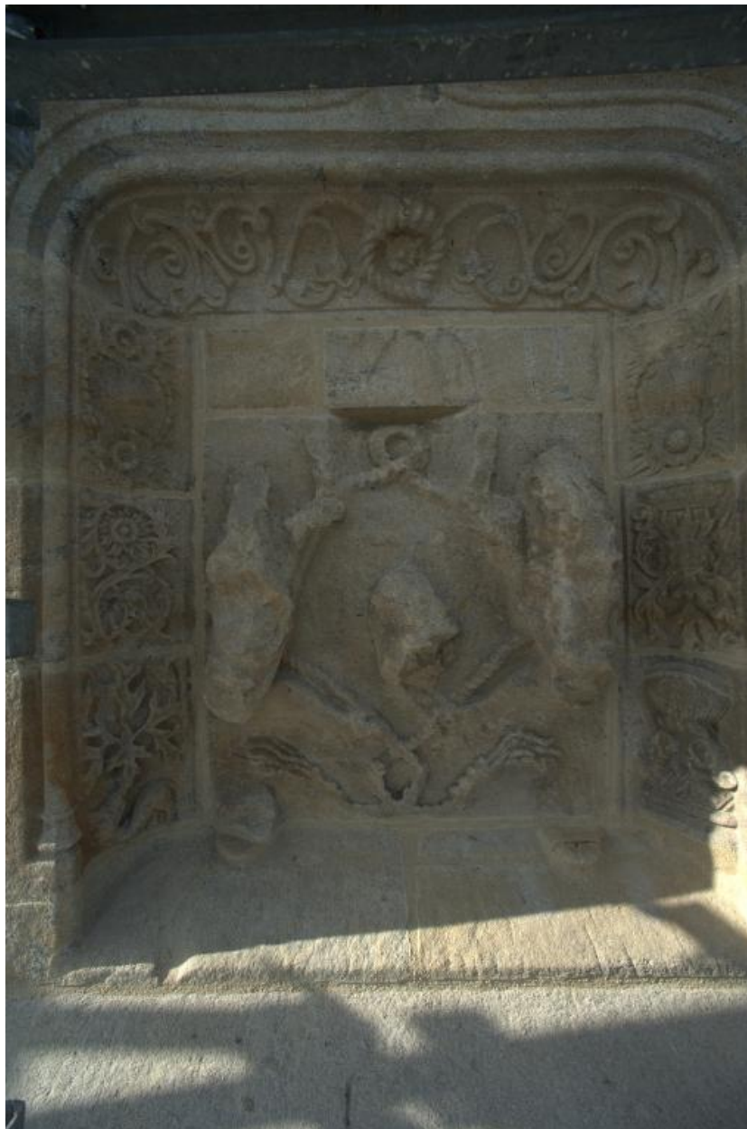
Niche au sommet du pignon du porche nord : armoiries bâchées
