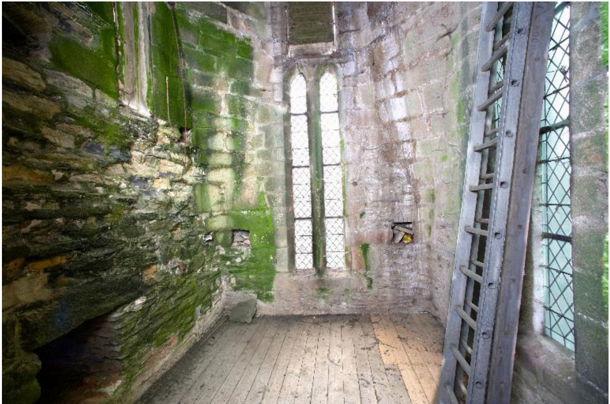
Tour sud-ouest, pièce de l'étage.
