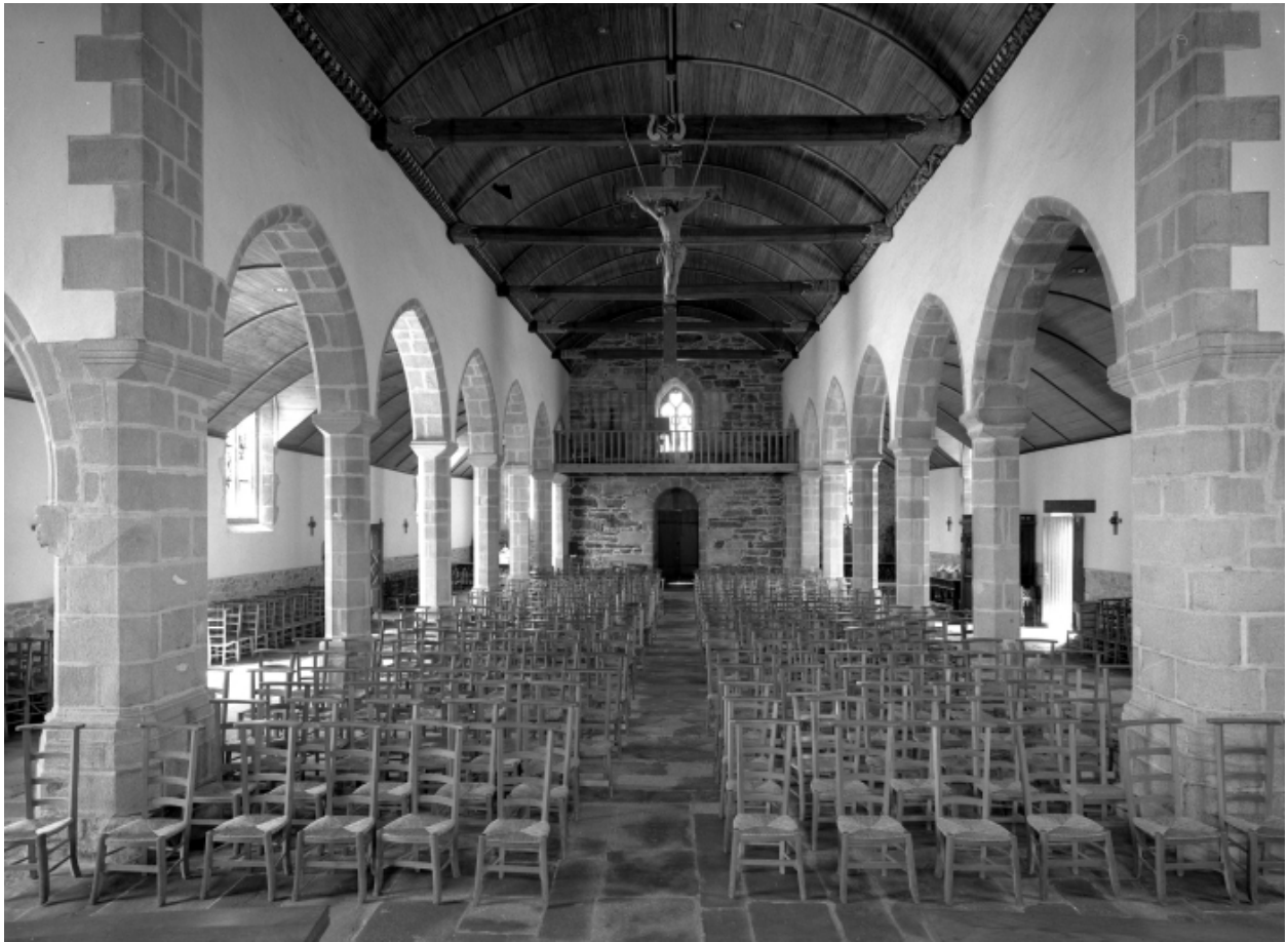
Plomodiern, église paroissiale Saint-Mahouarn : nef, vue générale vers l'ouest, état en 1970
