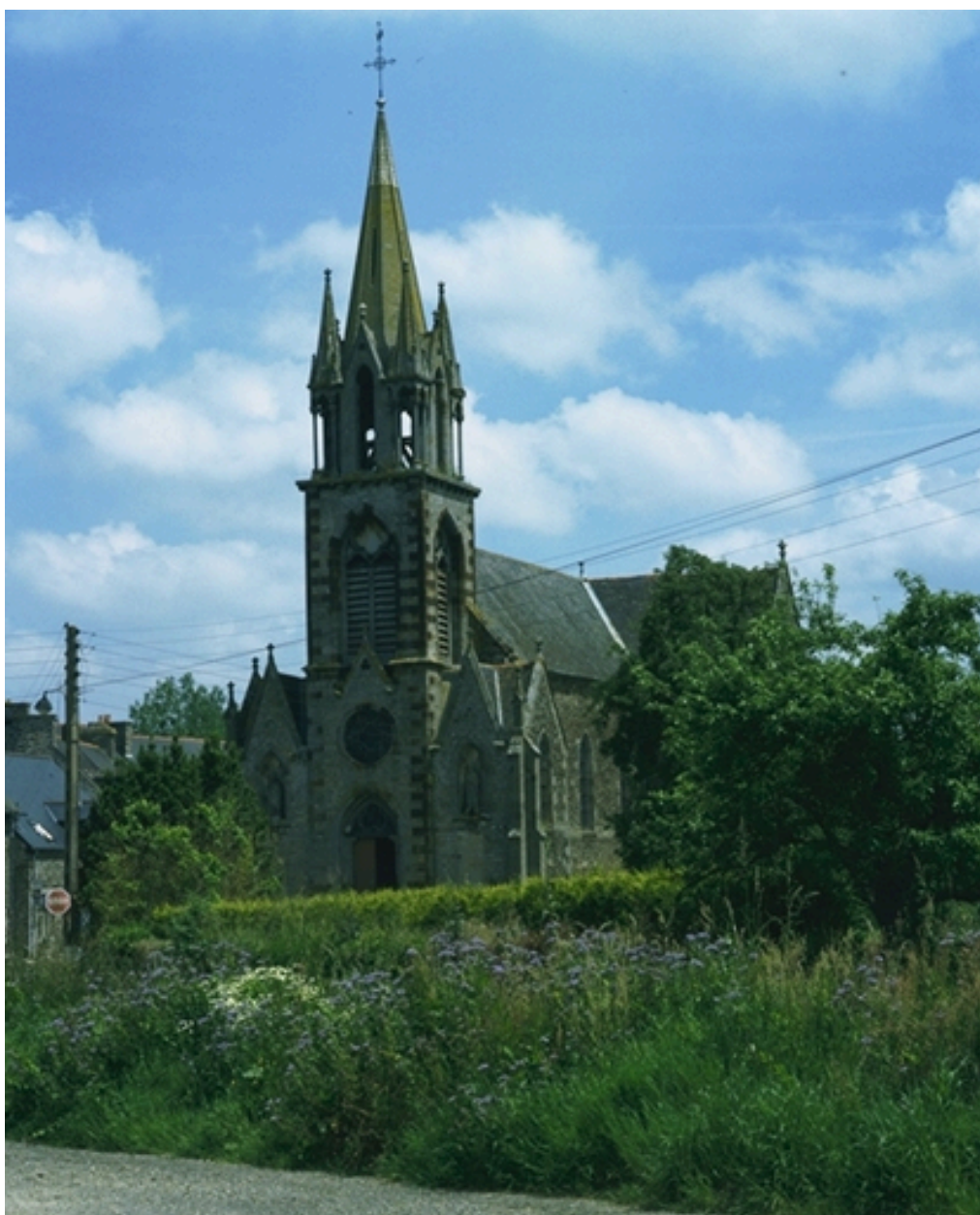
Vue de situation sud-ouest
