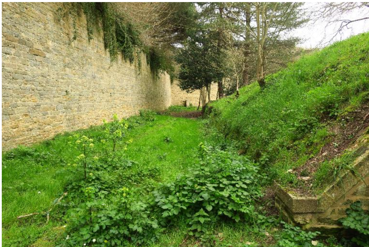
Le Palais, enceinte urbaine, courtine 19-20, partie gauche.
