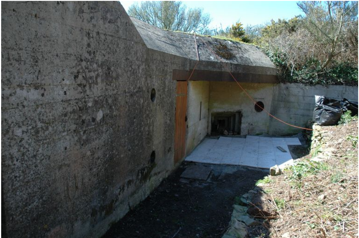
Vue de l'ensemble fortifié de la pointe du Renard : accès de la casemate de type 634 avec cloche blindée à 6 embrasures de type 20P7 (propriété privée)
