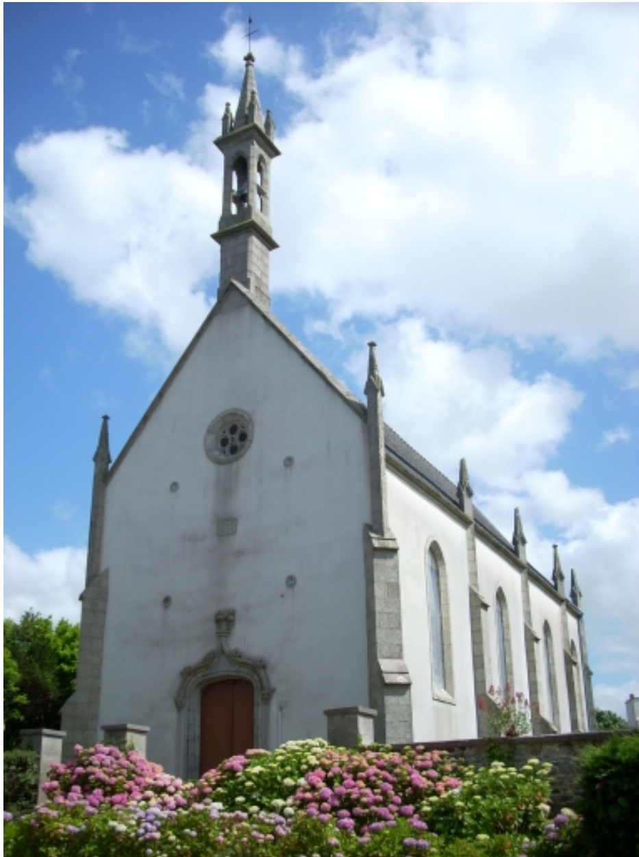
Plouider, chapelle Notre-Dame-des-Malades : vue générale sud-ouest
