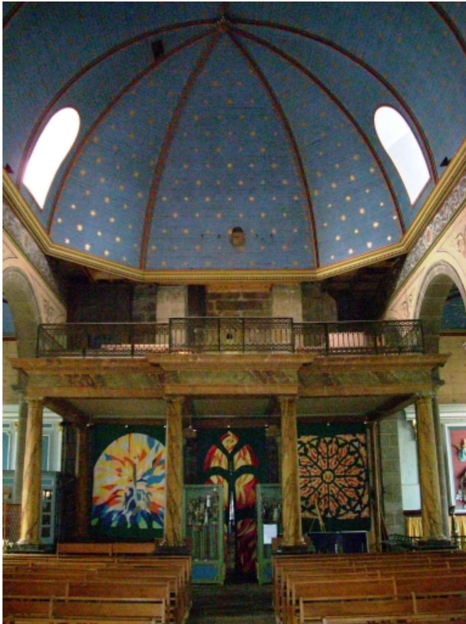
Plouguerneau, église paroissiale : vue de la tribune ouest
