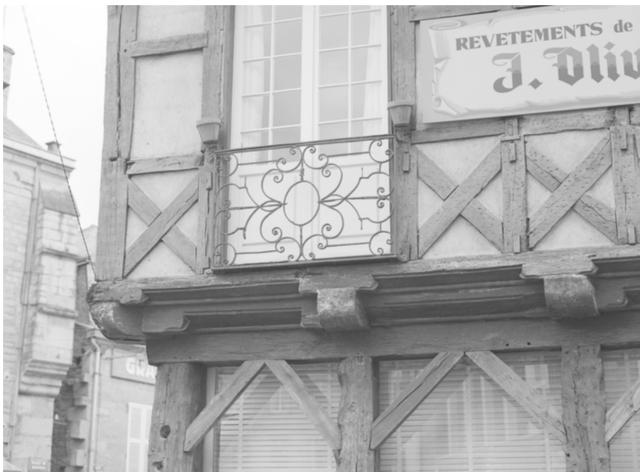
41 rue du Pont, détail garde-corps.
