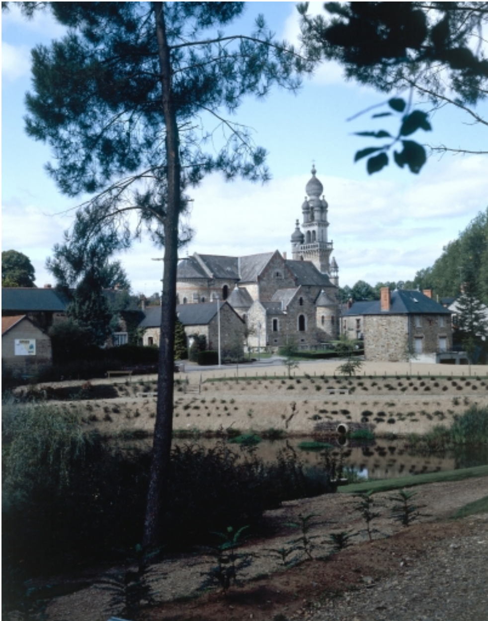
Elévation Ouest : vue générale
