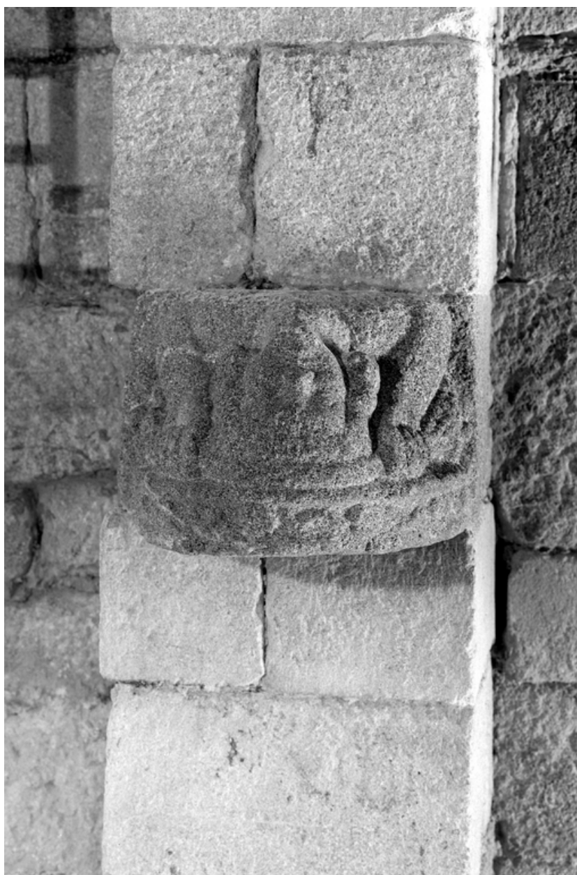
Nef, contrefort nord du mur ouest : détail du bénitier
