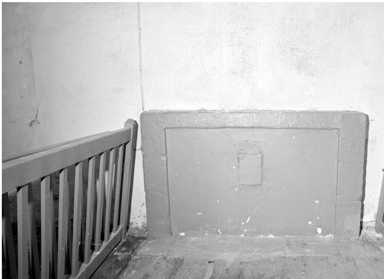
Chambre du premier étage, cheminée.
