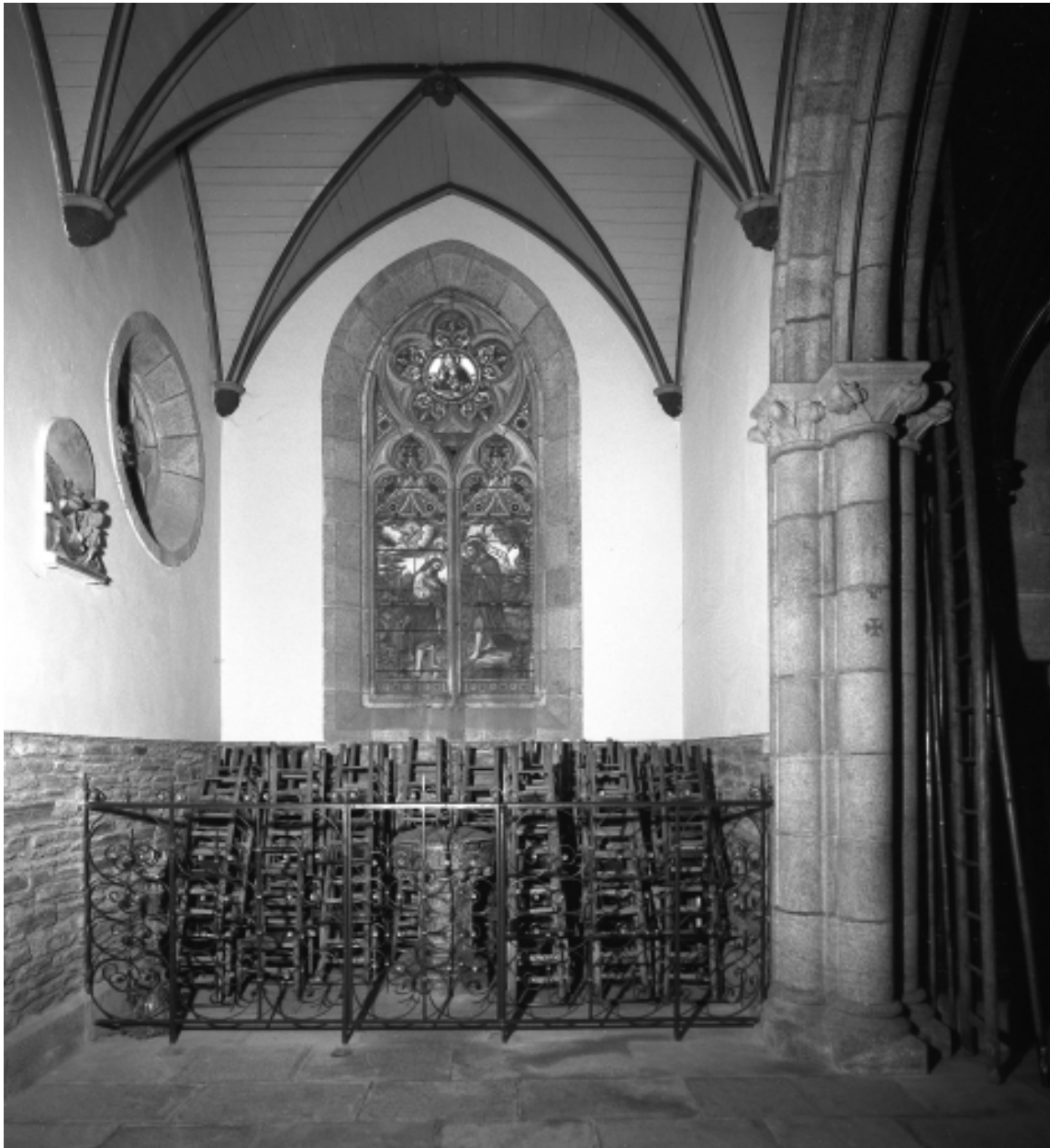
Châteaulin, église paroissiale Saint-Idunet : collatéral sud, chapelle des fonts à l'ouest, état en 1972
