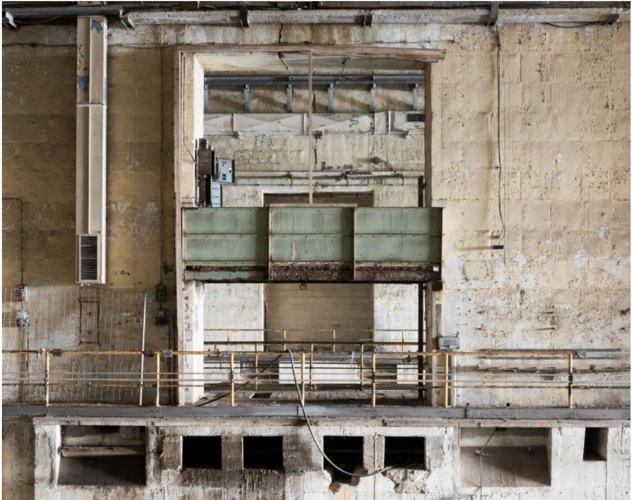
Vue de l'alvéole A (n° 24) : équipements électriques en place dans l'épaisseur du mur de refend situé entre les alvéoles A et B
