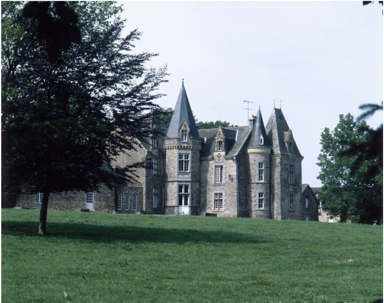
Logis, élévation nord-ouest.
