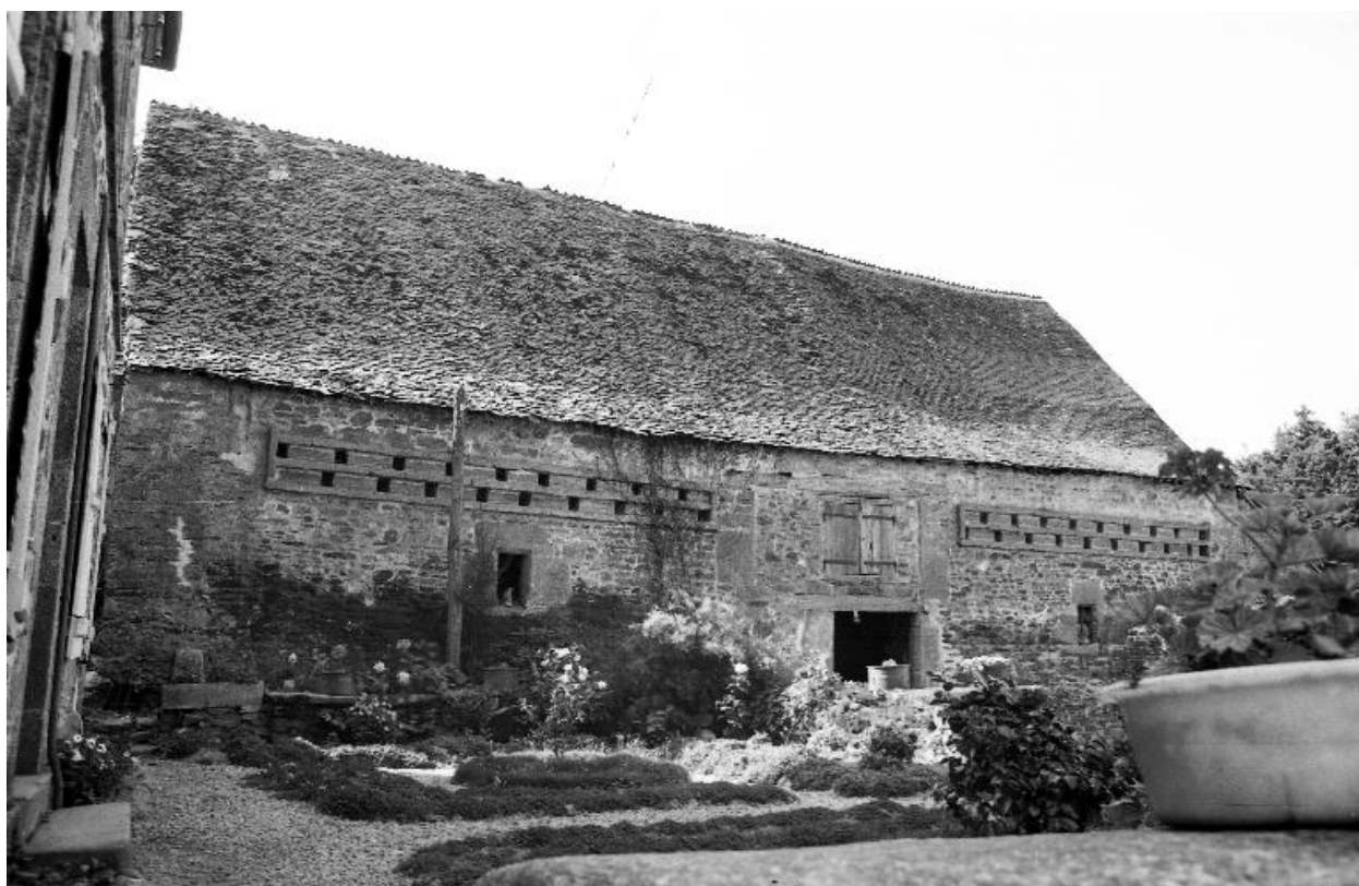
Communs, vue d'ensemble de la façade nord.
