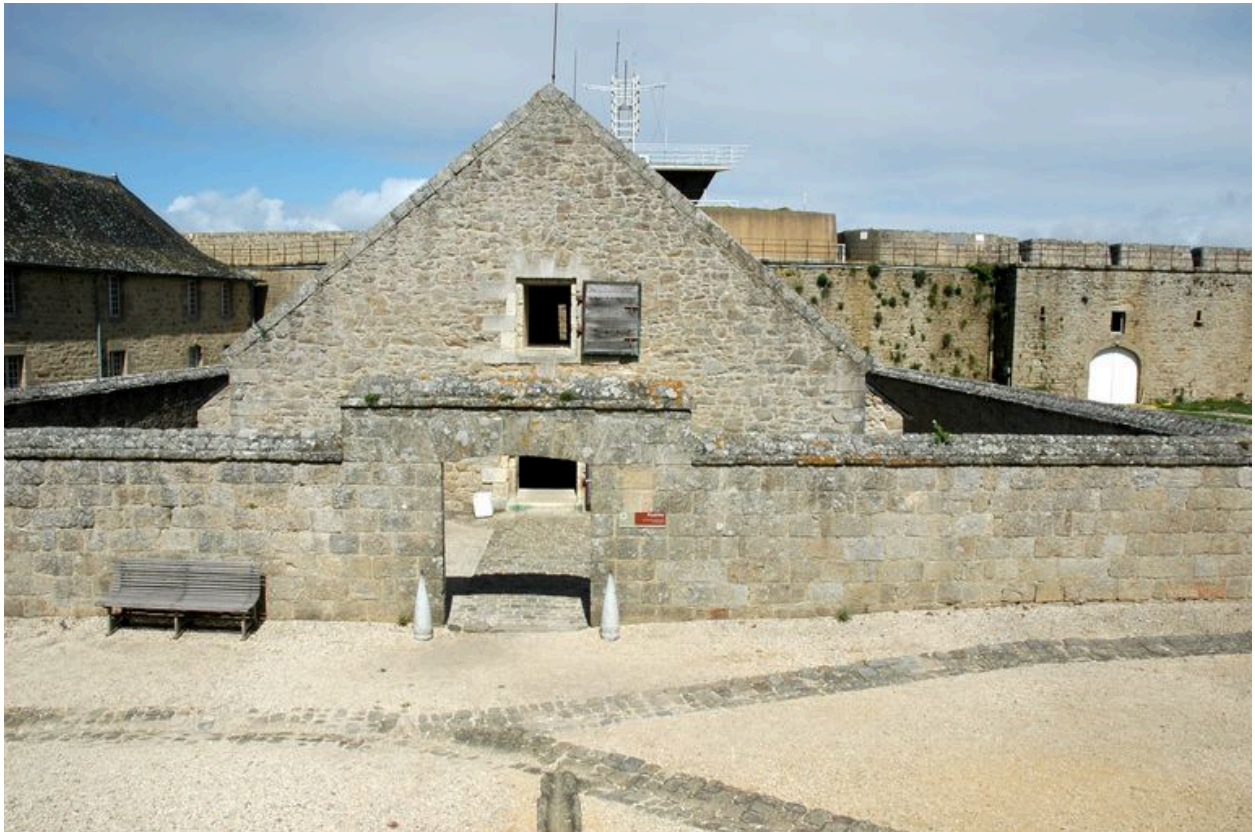
Vue de la citadelle de Port-Louis : magasin à poudre et son mur de sûreté
