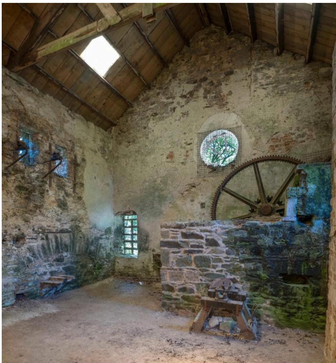
Bâtiment principal. Salle 1. Roue motrice et mur sud-est portant les traces de l'ancien moulin à papier
