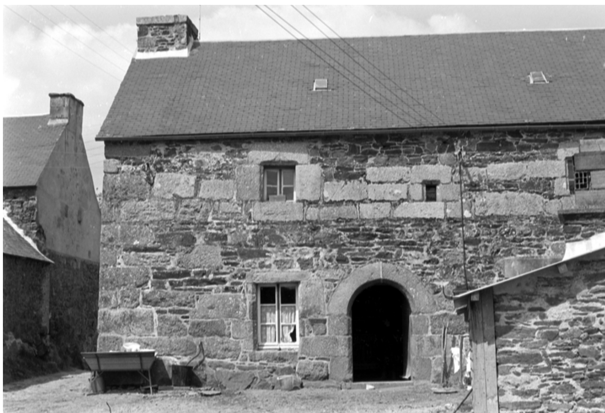
Maison (le château) : vue de la façade est
