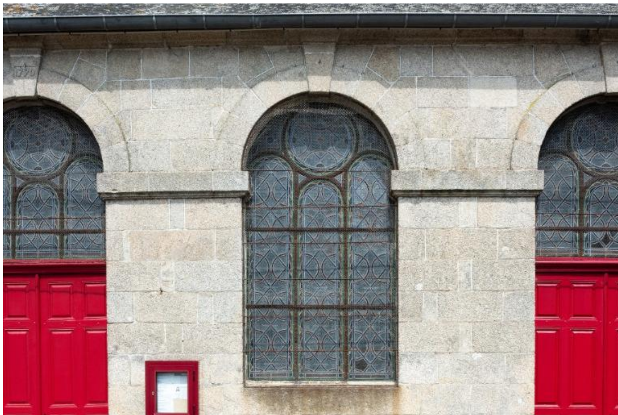
Ouverture collatéral sud
