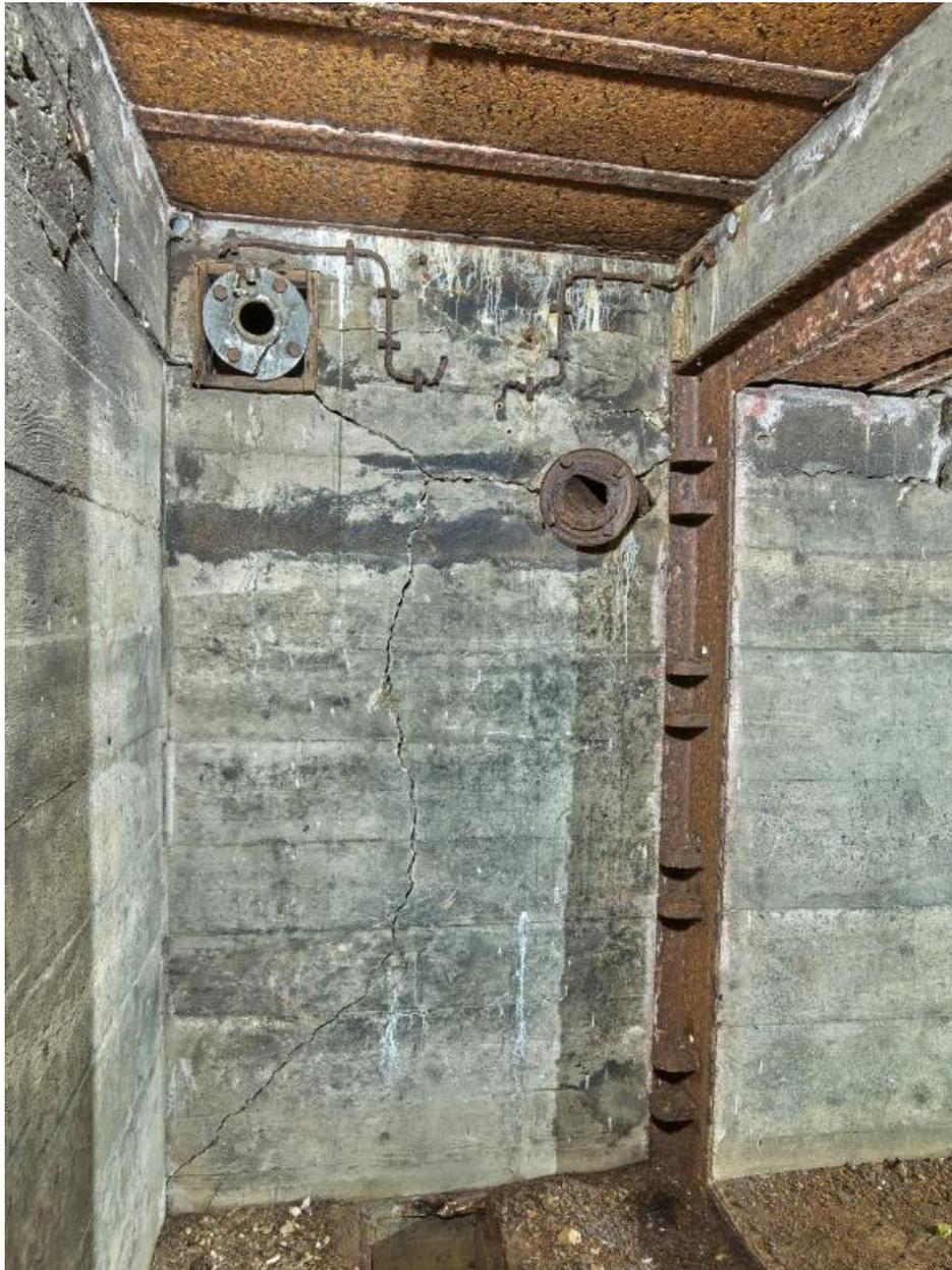
Vue de la petite pièce dédiée au périscopes : sur le mur, clapet de surpression en aluminium, bouche de soufflage et câblages (prises disparues). Cette petite pièce dite pièce périscopique était protégée par une porte blindée (disparue)
