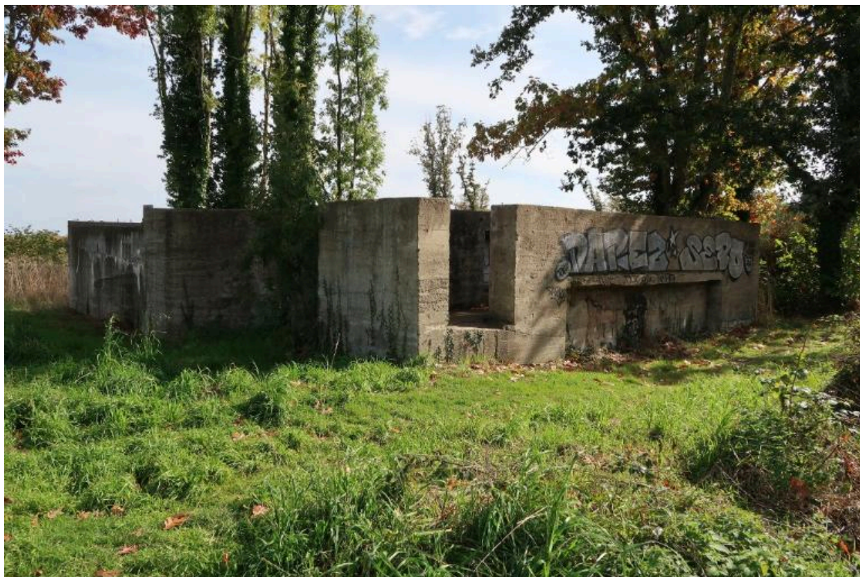
Vue du bunker-poste de direction de tir de type FI229 pour télémètre depuis le nord-ouest : entrée vers la cuve du télémètre
