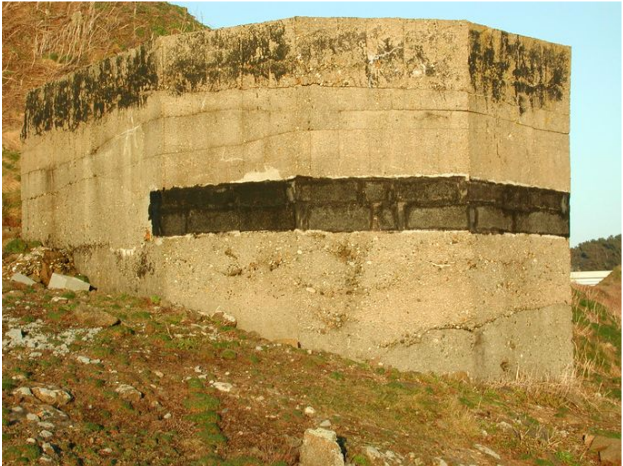
Vue du bunker situé en avant des bunkers - casemates (état en 2002)
