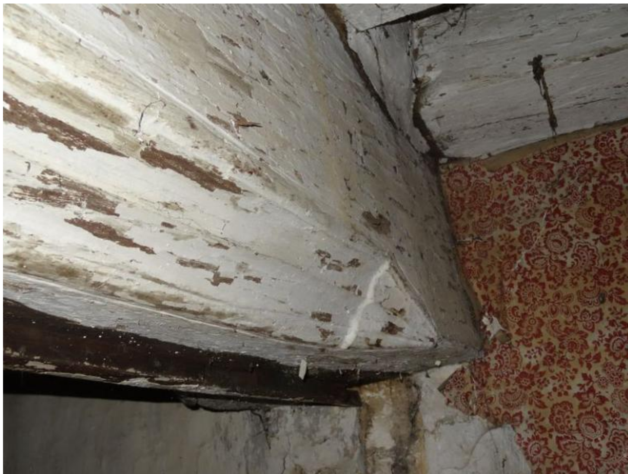
Détail d'une poutre du rez-de-chaussée
