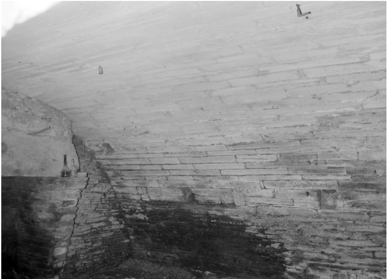
Maison : voûte du sous-sol (état en 1985)
